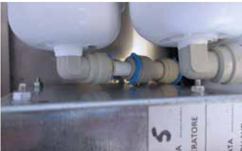
**Beachten Sie die richtige Reihenfolge:** Das Wasser durchläuft zuerst den Sedimentfilter, danach den Carbon-Filter.
