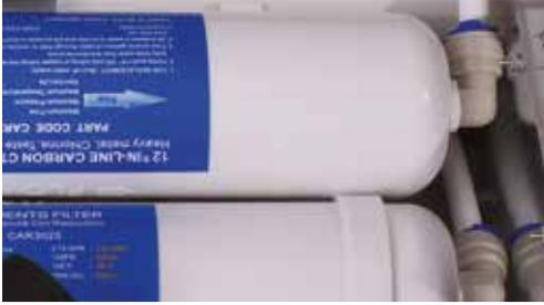
Sicherungsringe einschieben, Filterset wieder einsetzen.
