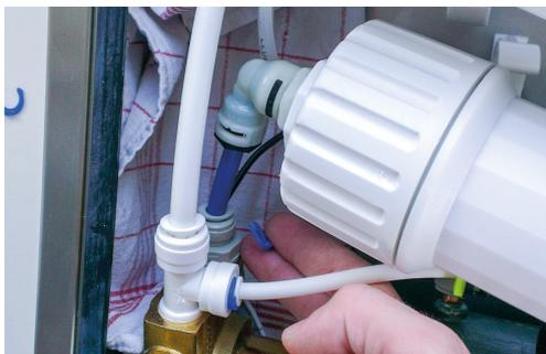
14. Anschließend entfernen Sie den blauen sowie den weißen 3/8" Schlauch. Bitte denken Sie daran, dass der Sicherungsring vor jedem Abziehen des Schlauchs entfernt werden muss.
