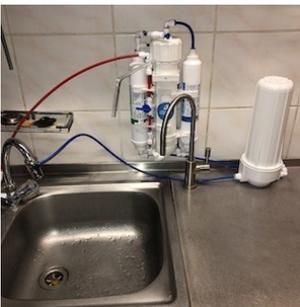
Der Kalkvorfilter muss senkrecht betrieben werden. Entweder wie auf dem Bild zu sehen mit den Schlauchanschlüssen nach unten oder alternativ mit den Schlauchanschlüssen nach oben.
