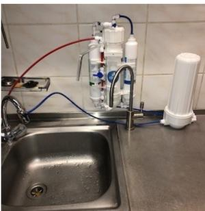
Der Kalkvorfilter muss senkrecht betrieben werden. Entweder wie auf dem Bild zu sehen mit den Schlauchanschlüssen nach unten oder alternativ mit den Schlauchanschlüssen nach oben.
